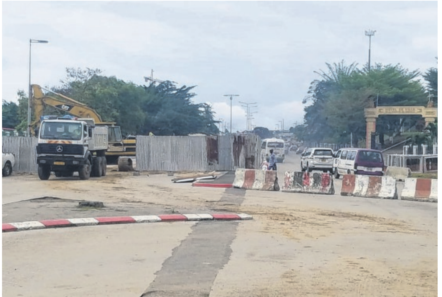
Les travaux se poursuivent sur le Boulevard Triomphal, entraînant de gros embarras de circulation.
