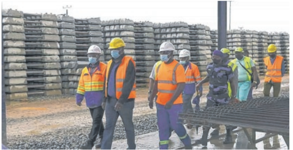
Les travaux en cours vont garantir plus de sécurité sur la voie ferrée.
