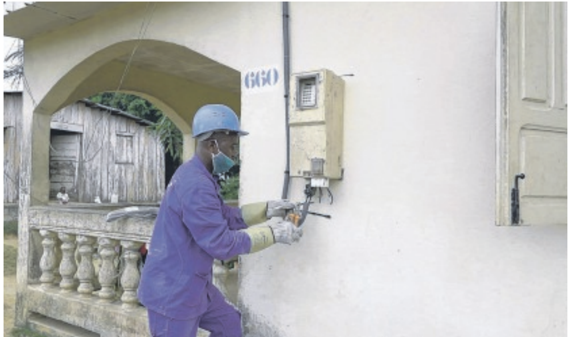
Compteur électrique en plein raccordement.
