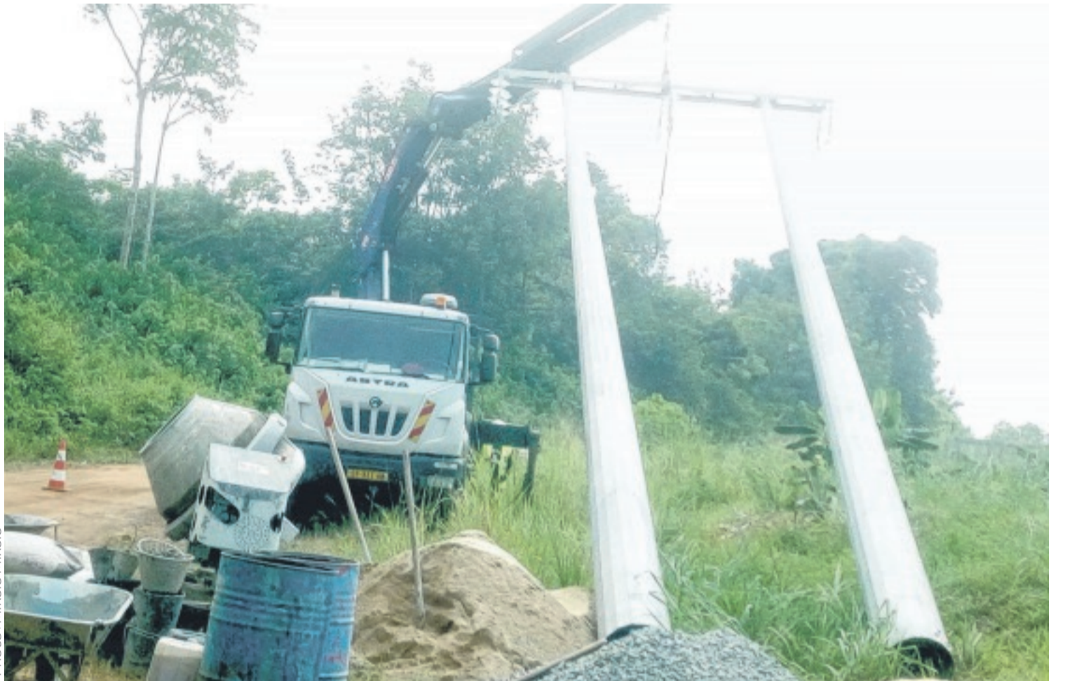
Pose de poteaux d'électricité à Malibe 2.
