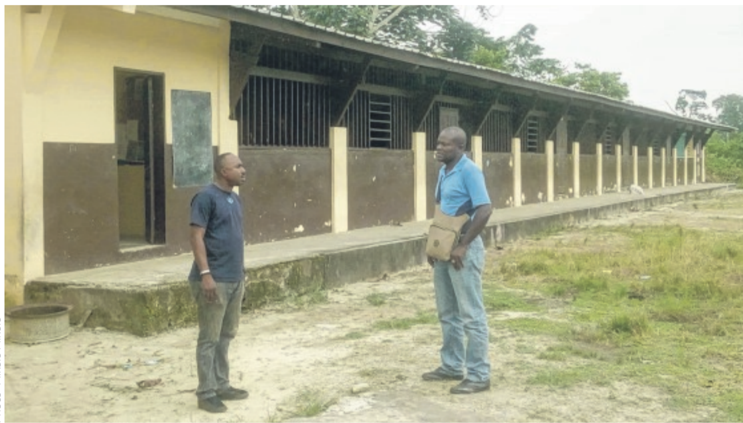
L'unique bâtiment abritant les salles de classe de l'école publique de Malibe 2.
