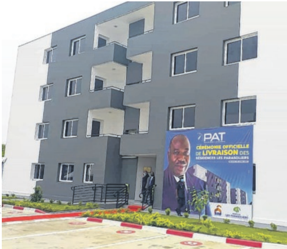
Une vue des logements des Parasoliers livrés par la Sni à Akanda.
