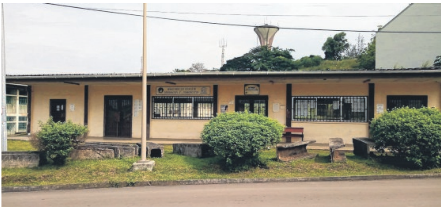
Une vue du bâtiment qui abrite le DSIC.
