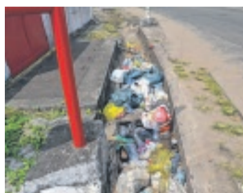
Un caniveau rempli d'ordures ménagères.
