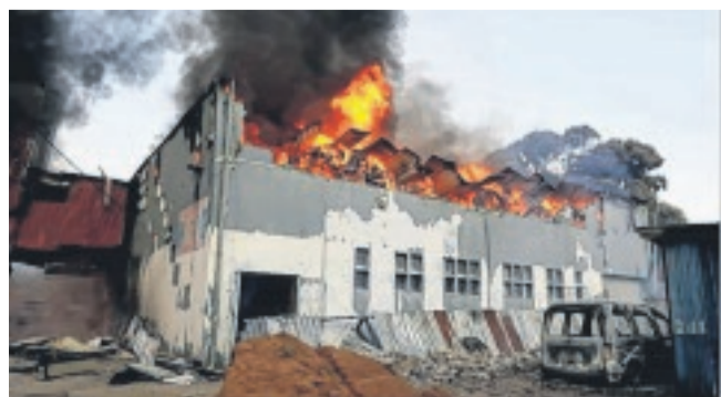
Des dégâts matériels importants.
