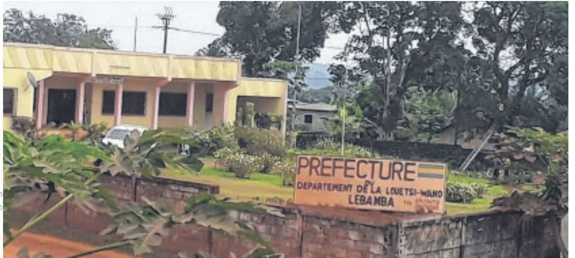
Une vue d'ensemble de la préfecture de Lebamba.
