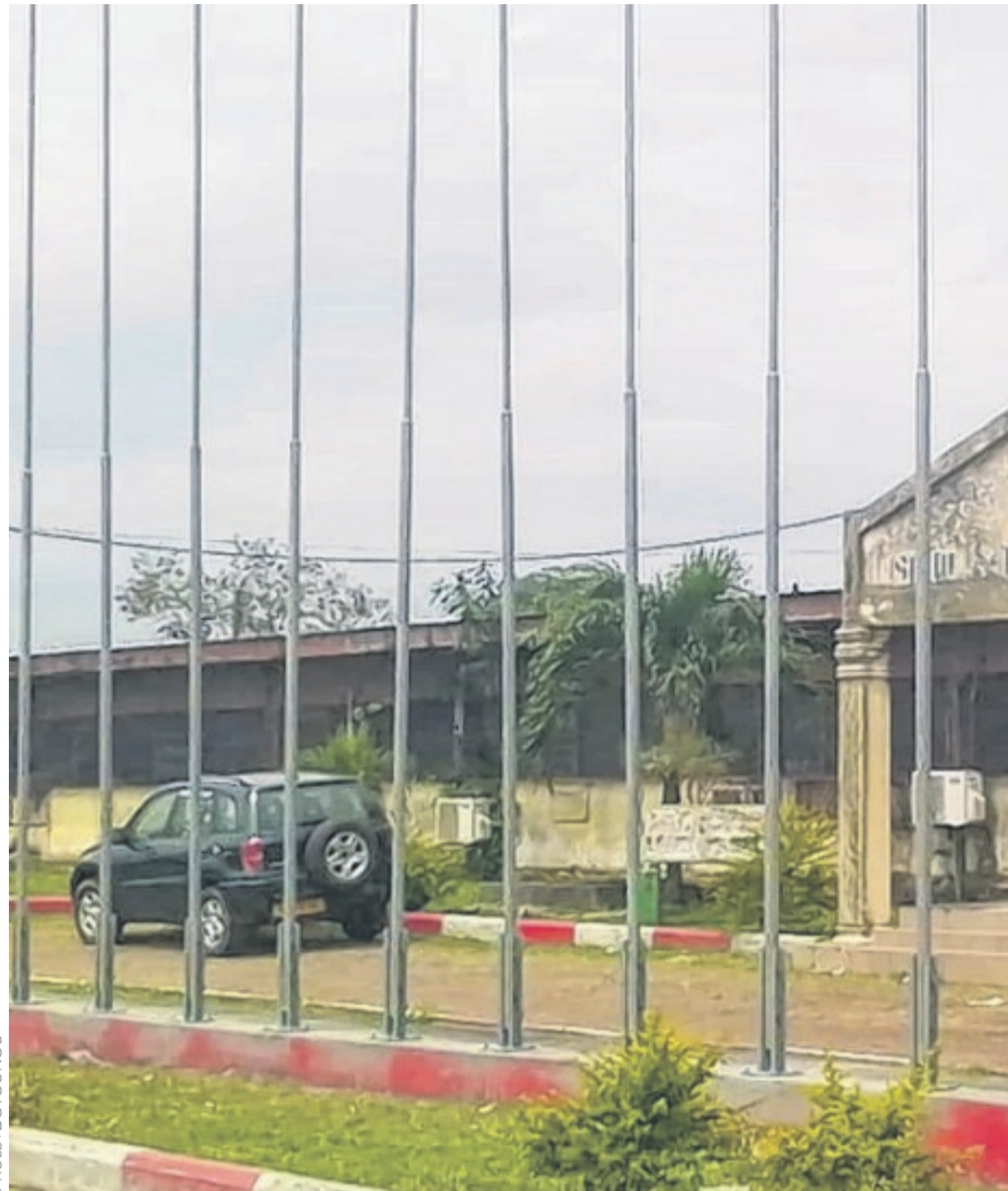
Des bâtiments vieillissants qui témoignent du peu d'intérêt désormais accordé à l'IAI.
