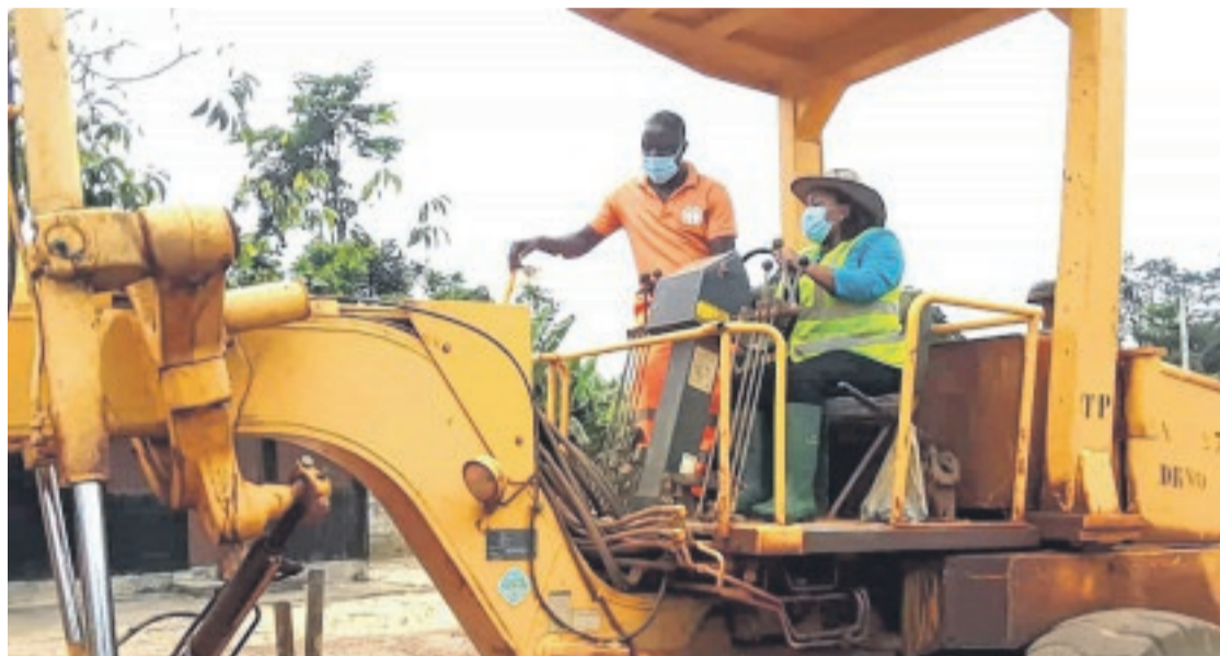
Camélia Ntoutoume Leclercq donnant le coup d'envoi des travaux.
