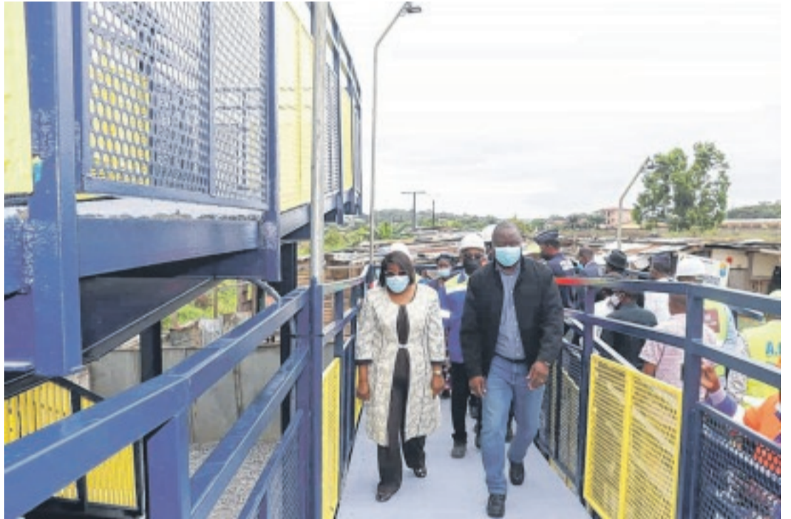
Une vue de la 4e passerelle du réseau ferroviaire.
