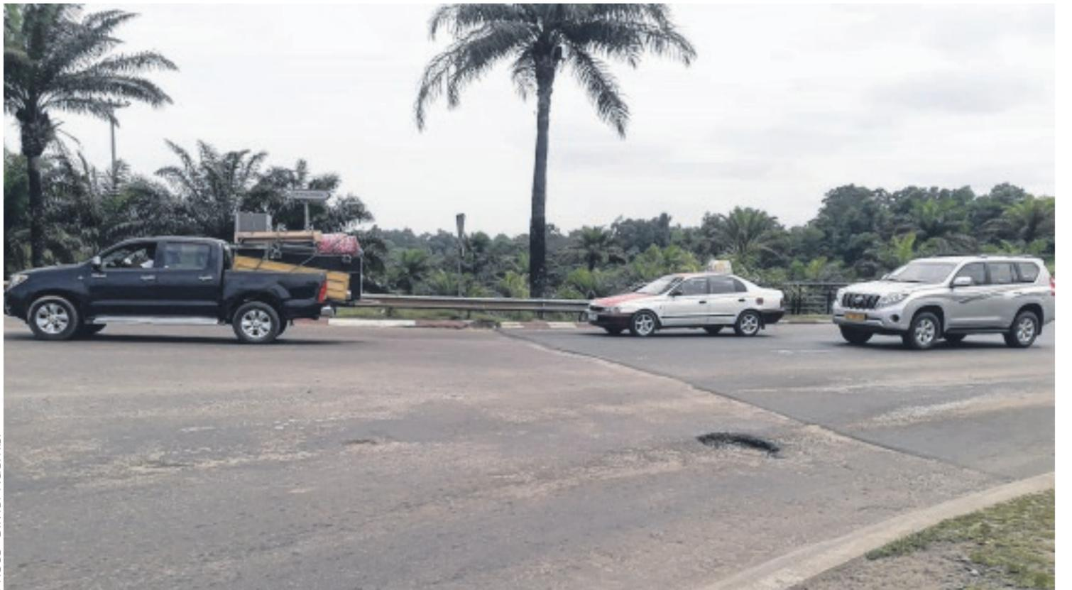
**Deux couches de bitume, deux épaisseurs différentes : les risques d'accidents ne sont pas à écarter sur l'échangeur du rond-point de la Démocratie.**
