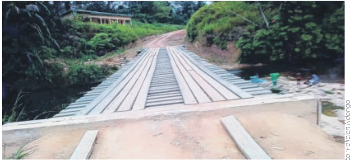
Un pont refait par les TP sur la route de la Mougala.
