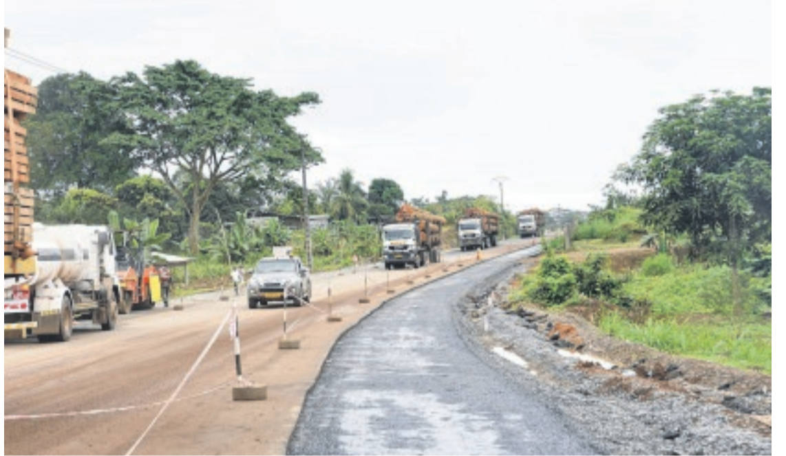
Les travaux de bitumage de la Transgabonaise ont commencé.
