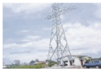
Vue d'un poteau électrique.
