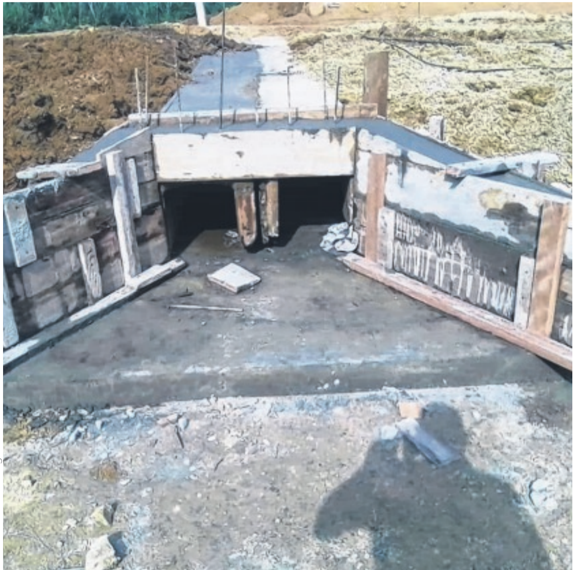
Des ouvrages comme ceux-ci sont en train d'être réalisés sur les différentes voies de la Ngounié.
