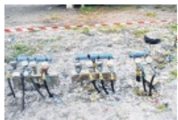
Vue des compteurs d'eau remplacés.
