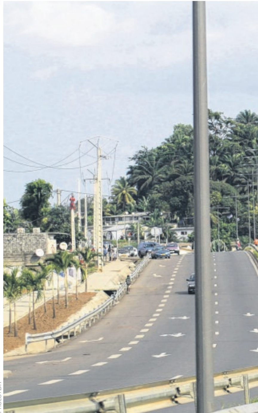
Le tronçon pk10 de la voie PK5 - PK12
