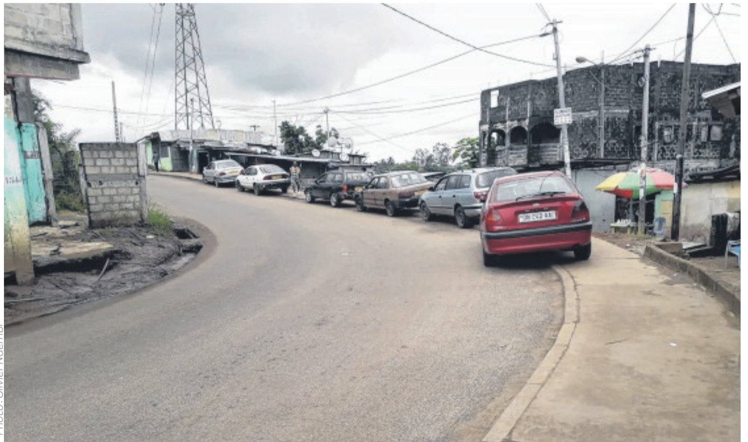
La circulation est redevenue normale après le débouchage du caniveau et du dalot sur cette voie.
