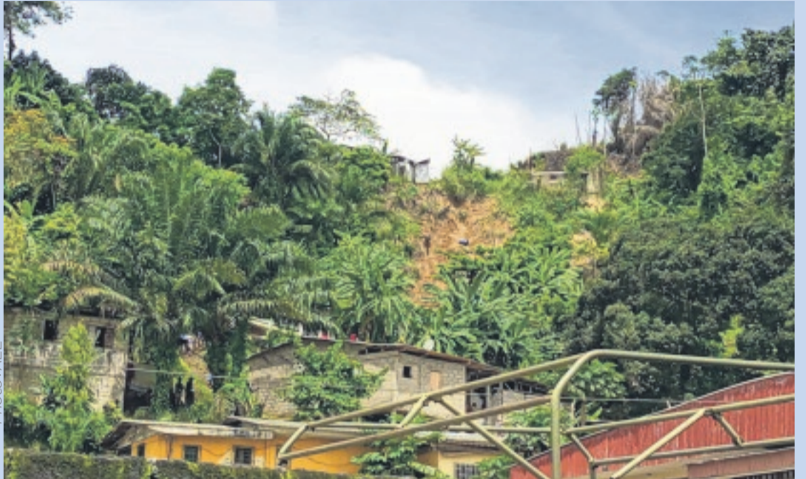
Le lieu de la tragédie du PK8.
