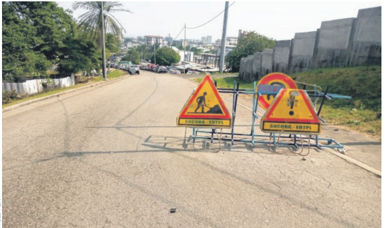
Avec le chantier ouvert depuis plus d'un an, la rue François Meye a cessé d'être fréquentée.
