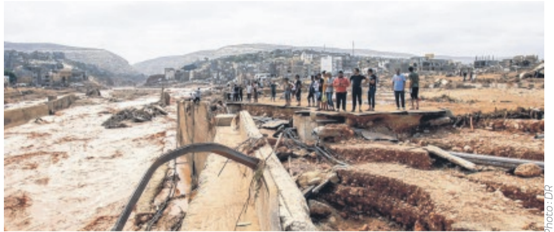
Les dégâts sont énormes dans cette ville côtière de Derna.
