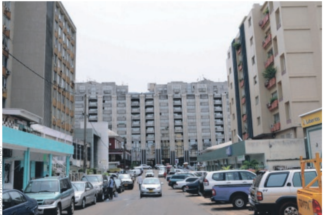
L'Immeuble Les Arcades (en face) qui abrite l'ambassade d'Afrique du Sud à Libreville.
