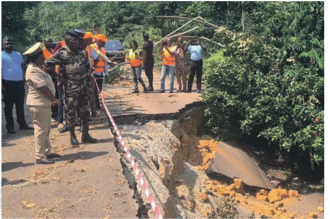
L'éboulement survenu sur un tronçon routier vieux d'à peine dix ans suscite bien des questions.
