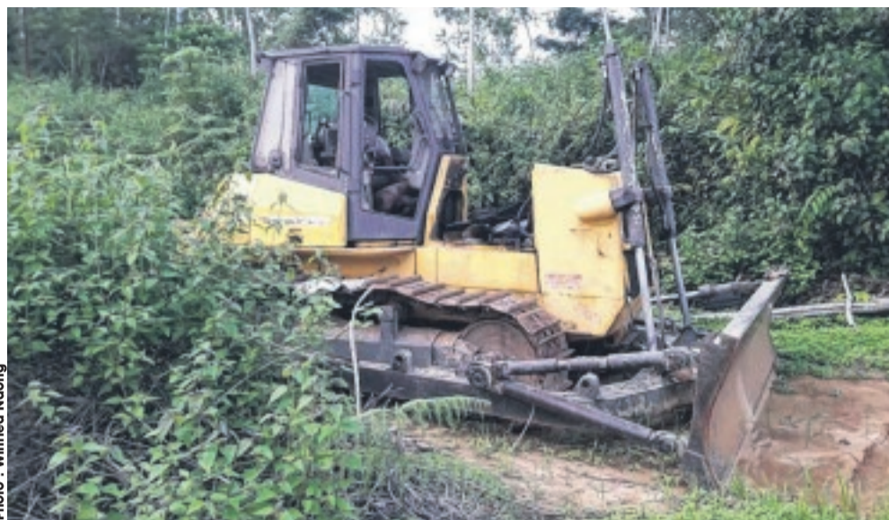
Les travaux sont tous arrêtés sur la totalité des espaces devant accueillir les plantations.
