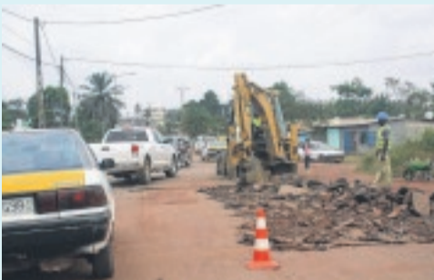
Bouchage des trous sur les voies principales.
