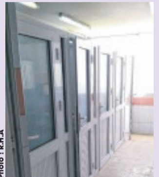
Des douches entièrement refaites.
