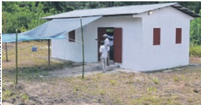
Le hangar abritant l'unité de conservation.
