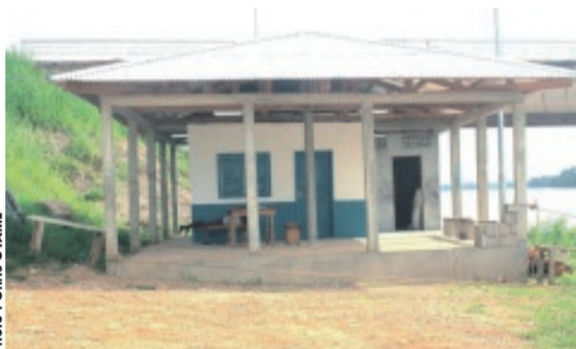
Les usagers disposent désormais de commodités avec la construction de ces toilettes publiques.
